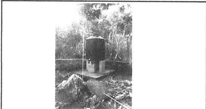
Foto 7: Mantenimiento de la cisterna del agua ya que le hacven falta sus accesorios para que funcione perfectamente
