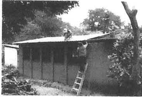
Foto 1: sustitucion de lámina ya que se encuentra deteriorada
